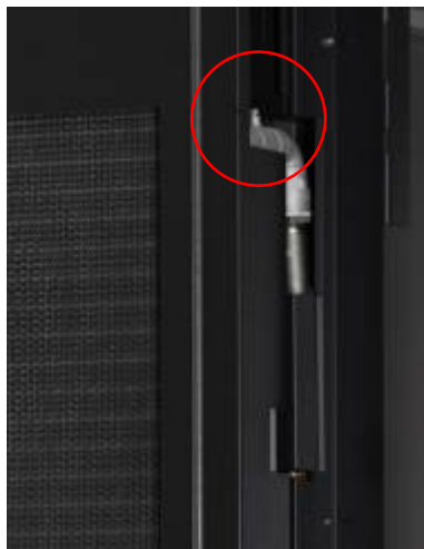
Abbildung 28 Einbauort des Entlüftungsventils
