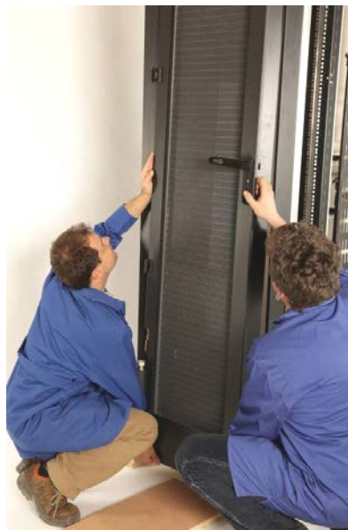
Abbildung 16 Einbau der Tür
