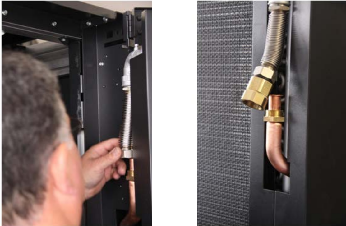
Abbildung 17 Flexible Wellenschläuche
