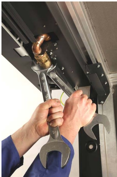
Abbildung 20 Festziehen der Überwurfmuttern
