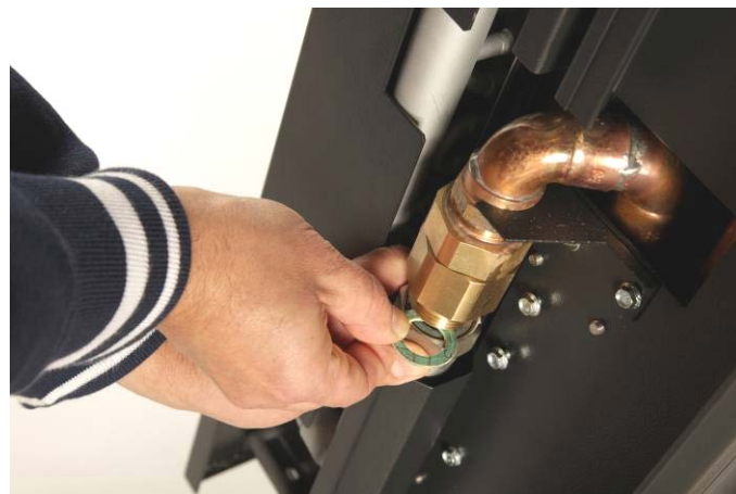
Abbildung 18 Einlegen des Dichtringes
