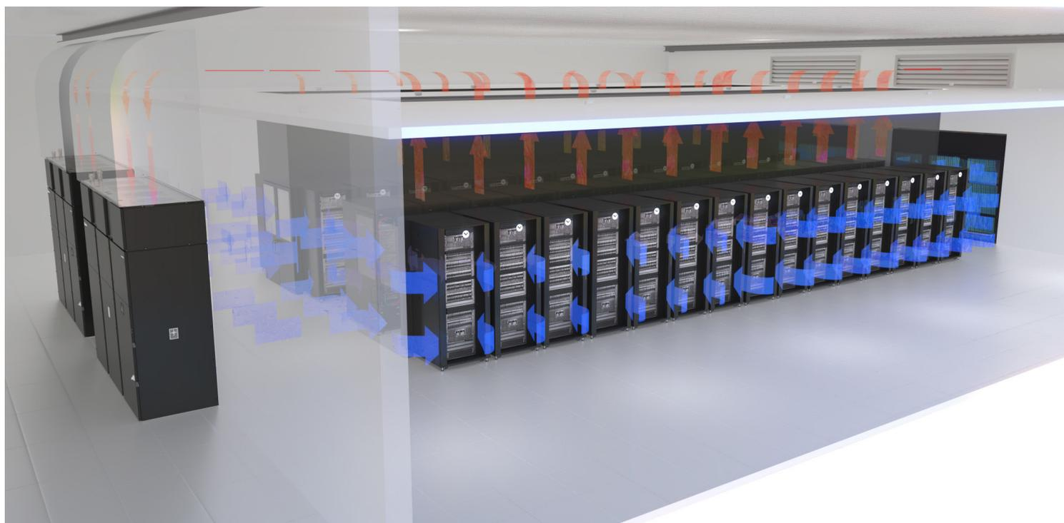
**Des unités de refroidissement murales (Thermal Wall) placées dans les couloirs de service :** Vertiv propose également une solution standard d'unité de refroidissement murale Liebert, basée sur le concept d'unité de traitement de l'air (AHU). Les Thermal Wall soufflent l'air horizontalement directement dans la salle serveur.
