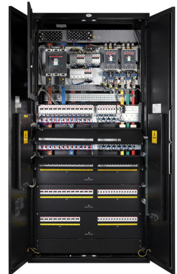
Solution de système d'énergie DC Vertiv™ NetSure™ 400V
